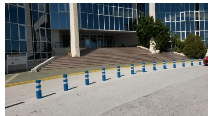
(1.6 Bolardos en entrada principal del CASEM)
